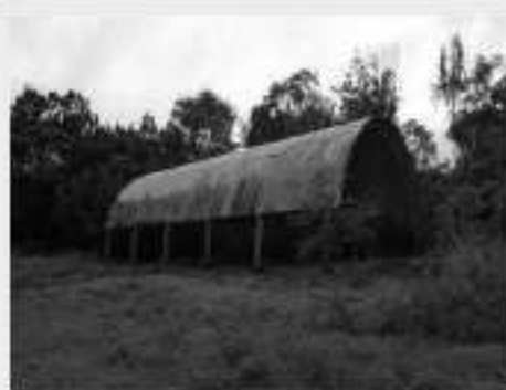
Vista parcial da Cobertura para Quadra Poliesportiva
