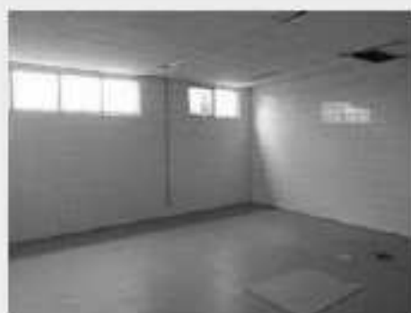
Vista parcial Interna Galpão Bloco "C"
