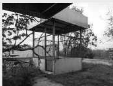
Vista parcial Cabine para Depósito de Inflamáveis - Bloco "C"
