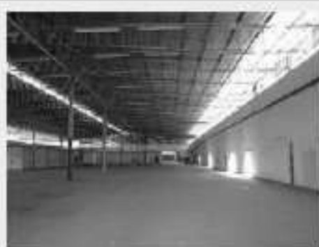
Vista parcial Interna Galpão Bloco "C"
