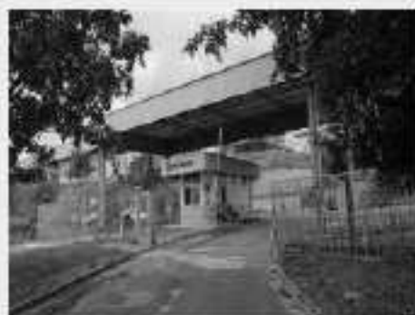
Vista parcial Cobertura e Cabine para Portaria 02
