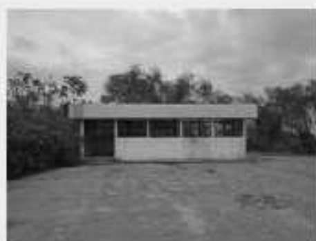
Vista parcial do Galpão para Inflamáveis - Bloco "A"
