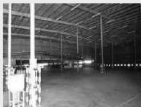
Vista parcial Interna Galpão Bloco "A"
