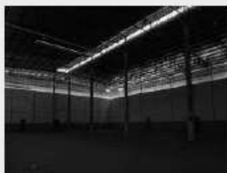
Vista parcial Interna Galpão Bloco "D"
