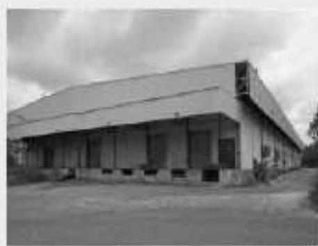
Vista parcial Galpão Bloco "C"
