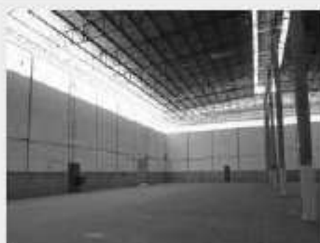
Vista parcial Interna Galpão Bloco "D"
