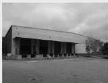
Vista parcial Galpão Bloco "A"
