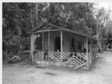
Vista parcial da Casa Sede
