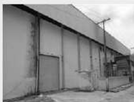
Vista parcial Galpão Bloco "B"
