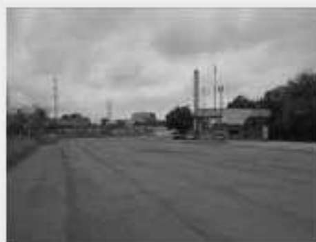
Vista parcial de Pátio para Estacionamento de Caminhões, junto à Portaria 01
