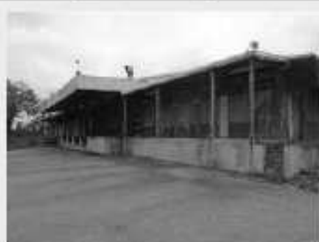
Vista parcial fundos do Galpão Bloco "A"
