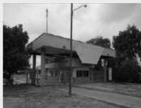
Vista parcial da Portaria 01
