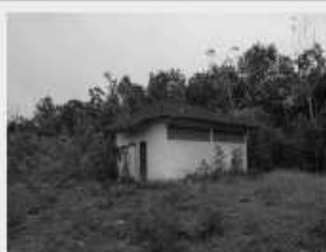
Vista parcial Prédio para Banheiros Junto à Quadra Poliesportiva
