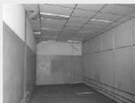
Vista parcial interna Galpão Bloco "E"
