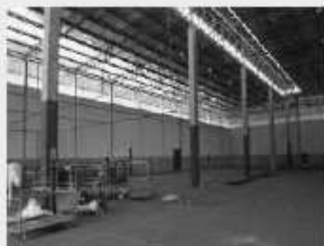
Vista parcial interna Galpão Bloco "E"
