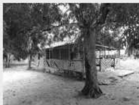
Vista parcial de Construção Auxiliar
