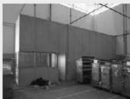
Vista parcial Interna Galpão Bloco "E"
