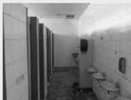
Vista parcial interna Galpão Bloco "C"
