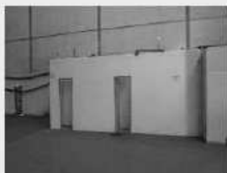
Vista parcial Interna Galpão Bloco "D"
