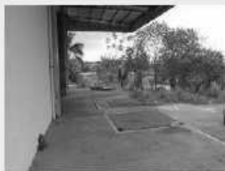
Vista parcial Galpão Bloco "E", Piaforma para Docas Carga / Descarga
