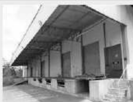
Vista parcial Galpão Bloco "C", Plataforma Docas Carga / Descarga
