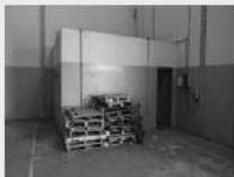
Vista parcial interna Galpão Bloco "E"
