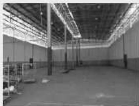
Vista parcial Interna Galpão Bloco "E"
