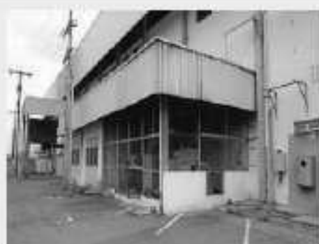
Vista parcial Galpão Bloco "B"
