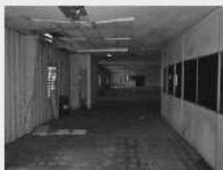
Vista parcial Interna Galpão Bloco "A"
