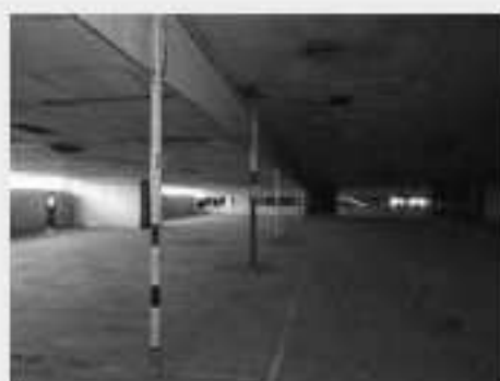
Vista parcial Interna Galpão Bloco "A"
