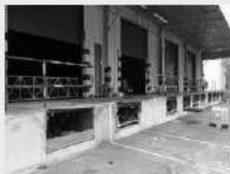
Vista parcial Galpão Bloco "A", Plataforma para Docas Carga / Descarga
