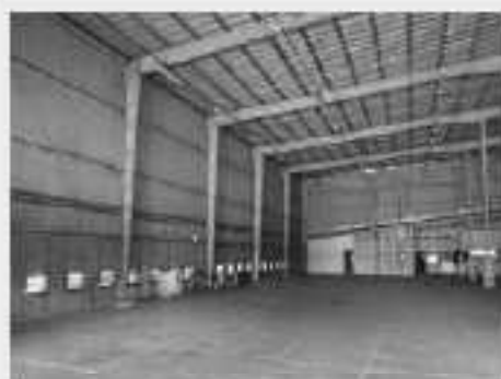
Vista parcial Interna Galpão Bloco "A"
