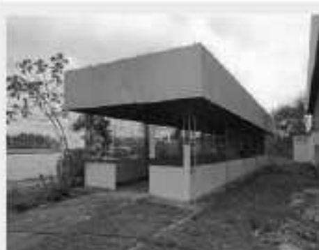
Vista parcial Depósito Inflamáveis - Bloco "B"
