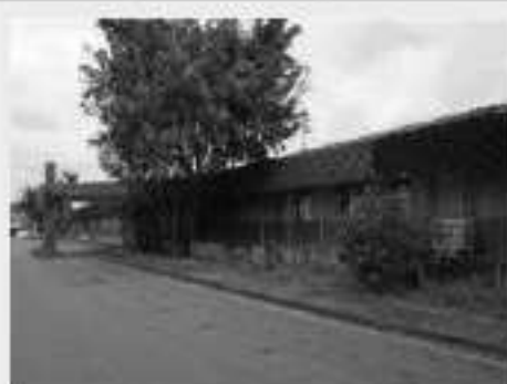
Vista parcial Galpão Bloco "A"
