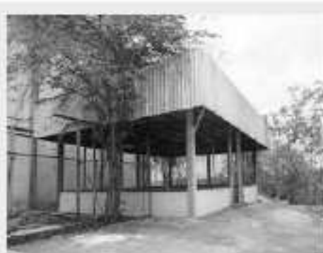
Vista parcial Galpão Setor Manutenção - Bloco "B"
