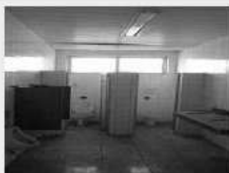
Vista parcial interna Galpão Bloco "C"
