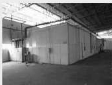
Vista parcial interna Galpão Bloco "C"
