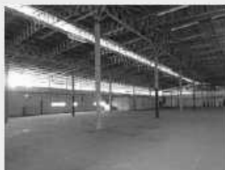
Vista parcial interna Galpão Bloco "C"
