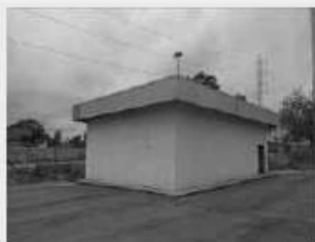
Vista parcial do Galpão para Depósito do Pátio de Caminhões
