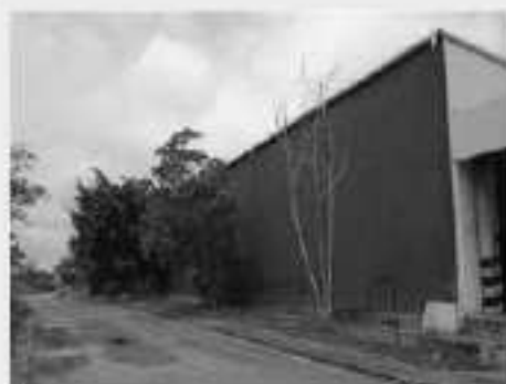
Vista parcial Galpão Bloco "A"
