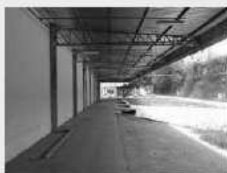
Vista parcial Interna Galpão Bloco "A", Plataforma para Docas Carga / Descarga
