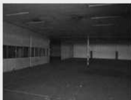
Vista parcial Interna Galpão Bloco "A"
