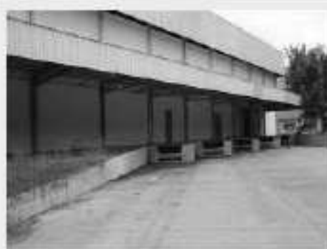
Vista parcial Galpão Bloco "D"
