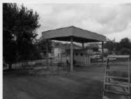
Vista parcial Cobertura e Cabine para Portaria 02
