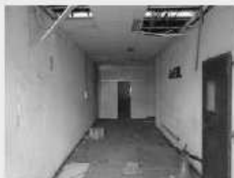
Vista parcial interna Galpão Bloco "C"
