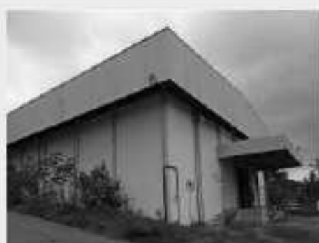
Vista parcial Galpão Bloco "E"
